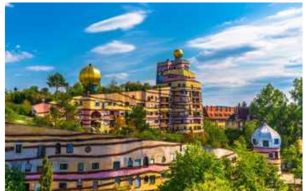
Abbildung 115 - Friedensreich Hundertwasser hat Gebäudebegrünung als wesentliches Gestaltungselement einer ökologisch orientierten Architektur eingesetzt, wie z. B. der Dachpark bei der Waldspirale in Darmstadt (Bild: Kiefer, flickr, CC BY 2.0).
