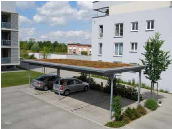
Abbildung 149 - Dachbegrünung auf Carport: Vermeidung von Aufheizung, Regenwasserrückhalt und ökologische Wertigkeit (Bild: Optigrün international AG).
