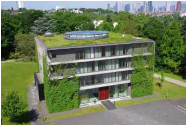
Abbildung 105 - Dach- und Fassadenbegrünung am Bürogebäude als Beitrag zu besserem Stadtklima und Biodiversität (Bild: Prof. Dr. Nicole Pfoser, HfWU Nürtingen, Kompetenzzentrum für Gebäudebegrünung und Stadtklima e.V.).
