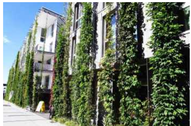
Abbildung 111 - Bodengebundene Fassadenbegrünung mit Rankgerüst: Guter, sommerlicher Schutz vor Sonneneinstrahlung (Bild: faktorgreen).
