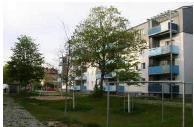
Abbildung 102 - Gutes Beispiel für halböffentliches Zwischengrün: Retentionsraum für Regenwasser, wasserdurchlässige Parkplätze, Kinderspielplatz und Neupflanzung großkroniger Laubbäume (Bild: faktorgruen).
