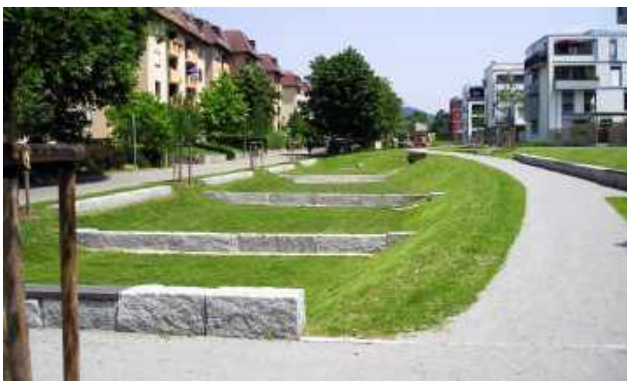
Abbildung 118 - Multifunktionale Flächennutzung im Wohngebiet: Aufenthaltsqualität und Retentionsvolumen (Bild: Stadtteilpark Peter-Sprung-Straße - Freiburg, AG Freiraum, Daniel Schönen).
