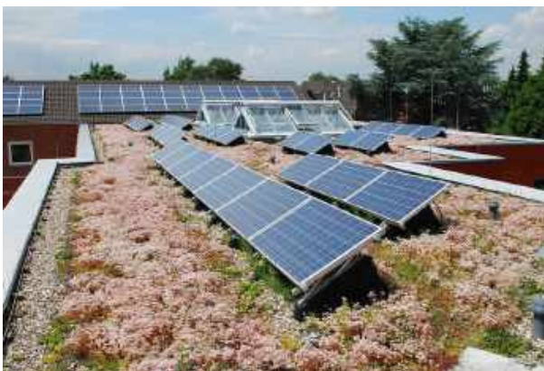
Abbildung 110 - Fachgerechte Ausführung von extensiver Dachbegrünung mit PV-Anlagen: Regenwasserretention, Biodiversität, verbessertes Stadtklima und Energiegewinnung (Bild: Bild: EKS Langenfeld, Optigrün international AG).
