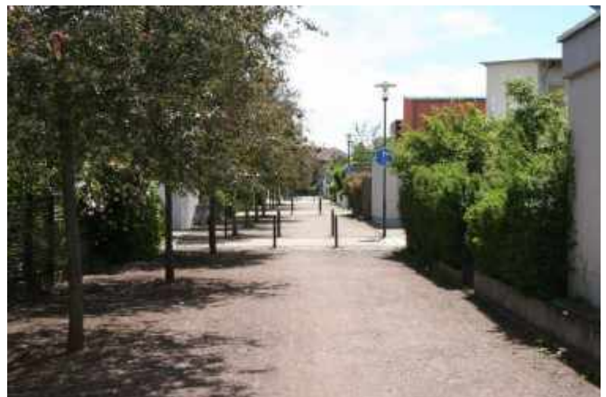
Abbildung 142 - Klimaangepasste Fuß- und Radwege im Quartier Vauban: Wasserdurchlässig und beschattet (Bild: faktorgruen).
