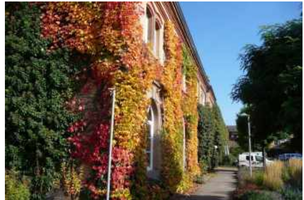
Abbildung 113 - Auch denkmalgeschützte Gebäude können durch Fassadenbegrünung aufgewertet werden, wie hier das Gebäude des Tiefbauamts in Ludwigsburg (Bild: Stadt Ludwigsburg).
